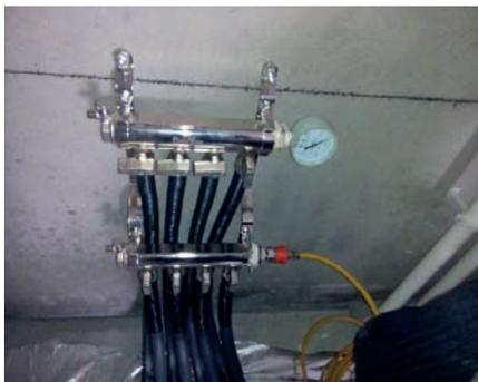
图 9-54 打压试验
