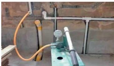
图 8-22 连接打压泵
