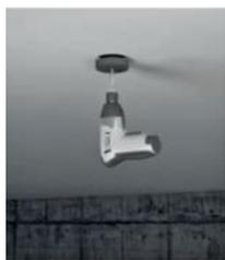
图 7-59 吊顶打孔
