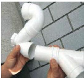
图 8-19 直接插入管件
