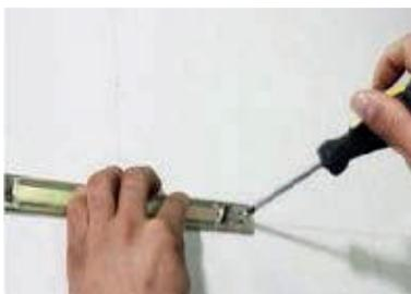
图 9-40 固定安装挂件
