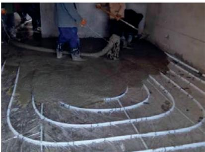
图 9-55 回填水泥砂浆层
