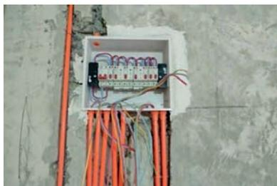
图 7-3 安装完成后的家用配电箱
