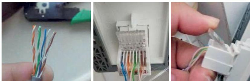
图 7-44 剥网络线外皮 图 7-45 网络线插入压线板 图 7-46 用力扣紧色标盖
