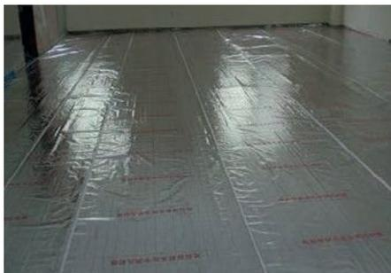
图 9-51 铺设反射铝箔膜
