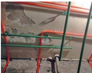
图 8-6 顶面水管弹线
