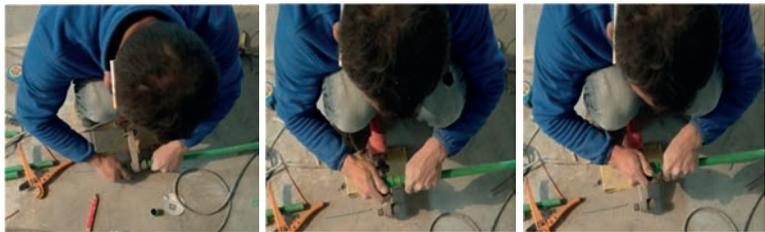
图 2-16 热熔器操作步骤
