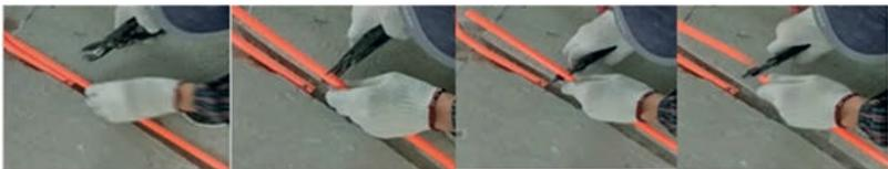
图 2-14 PVC 断管钳操作步骤
