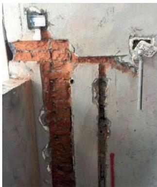
图 8-7 墙面开槽
