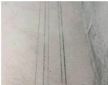
图 8-4 地面水管弹线
