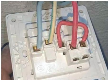
图 7-28 开关控制插座连线示意
