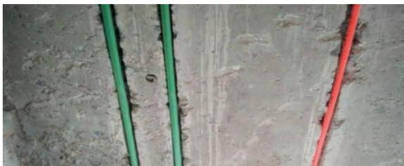
图 1-18 PP-R 水管与 PVC 线管
