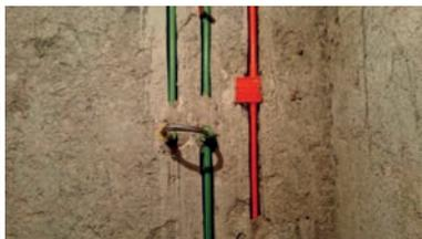
图 8-21 冷热水管连接
