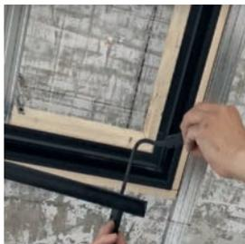
图 7-68 安装连接线
