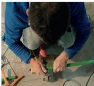
图 8-14 PP-R 热熔至凸缘
