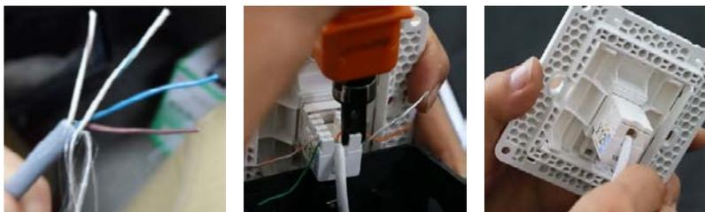
图 7-39 剥电话线外皮 图 7-40 线芯连接到端子上 图 7-41 盖防尘盖
