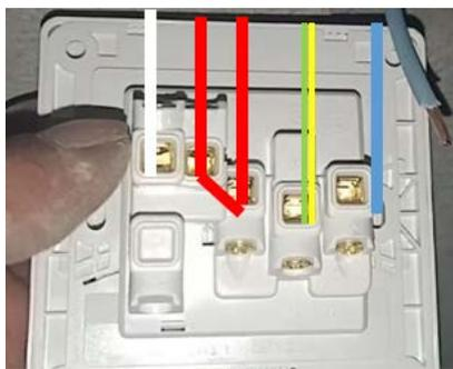
图 7-29 开关控制灯连线示意
