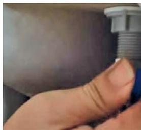
图 9-31 软管与水箱配件的水阀连接
