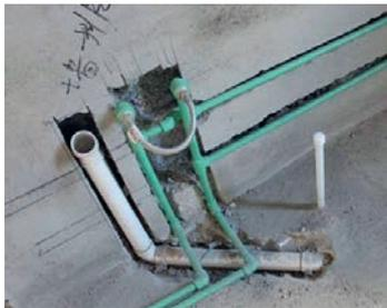
图 8-5 墙面水管弹线
