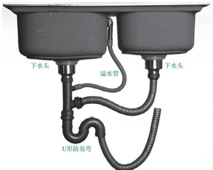
图 9-1 水槽下水组件安装示意
